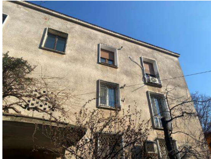
Figura 7.3 Clădire cu structura din zidărie nearmată și planșee rigide la acțiuni în planul lor, amplasată în București
