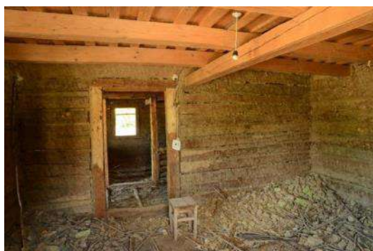
Figura 7.19 Structura cu bârne de lemn ecarisat
