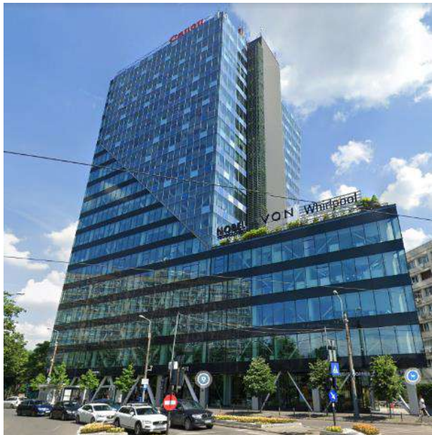
Figura 7.15 Clădire cu structura în cadre contravântuite din oțel amplasată în București
