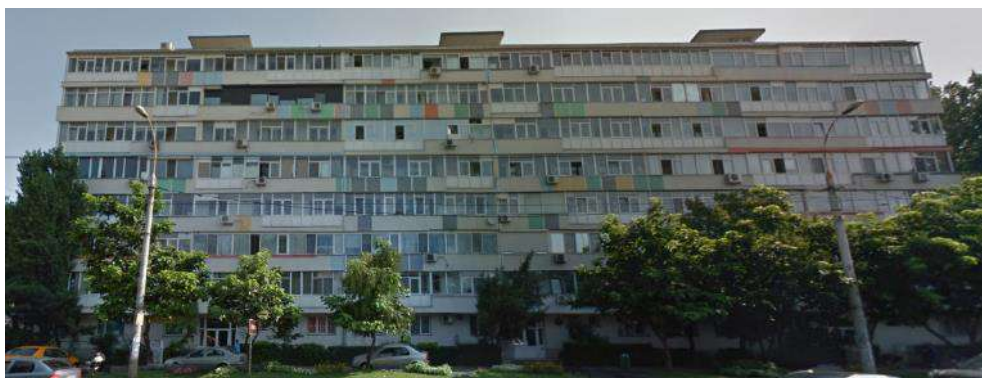
Figura 7.11 Clădire cu structura realizata din panouri mari prefabricate din beton armat amplasată în București, construită înainte de 1977 (înainte și după reabilitarea termică) (sursa: google maps)
