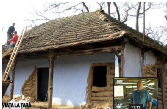
Figura 7.18 Structura cu bârne de lemn rotund
