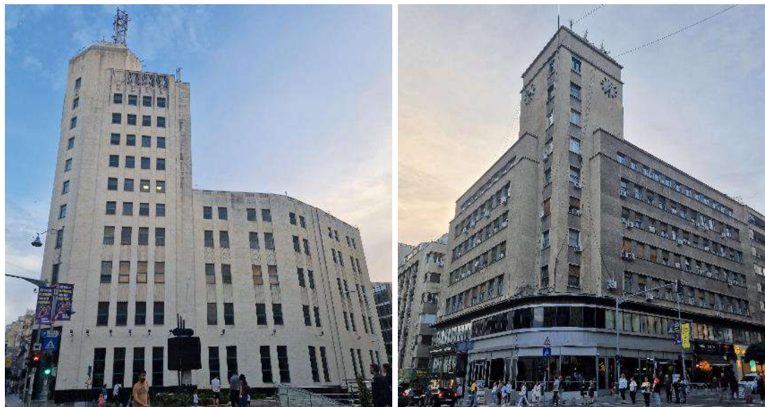
Figura 7.14 Clădiri cu structura în cadre cu noduri rigide din oțel amplasate în București (Palatul Telefoanelor, clădirea Adriatică)
