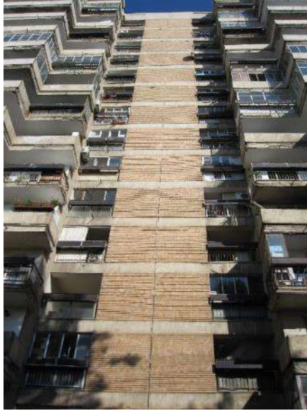
Figura 7.8 Clădire cu pereți structurali amplasată în București
