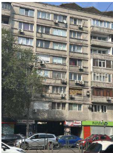
Figura 7.12 Clădire cu structura de beton armat cu parter flexibil amplasată în București
