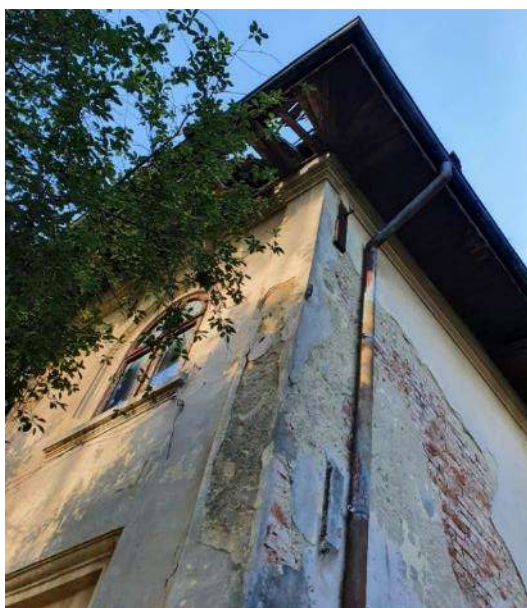
Figura 7.2 Clădire cu structura din zidărie nearmată și planșee flexibile la acțiuni în planul lor, amplasată în București
