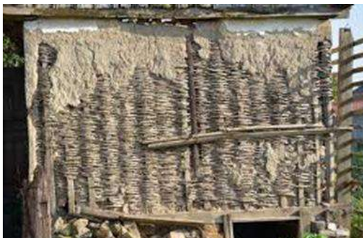
Figura 7.20 Casa cu perete structural din împletituri de nuiele
