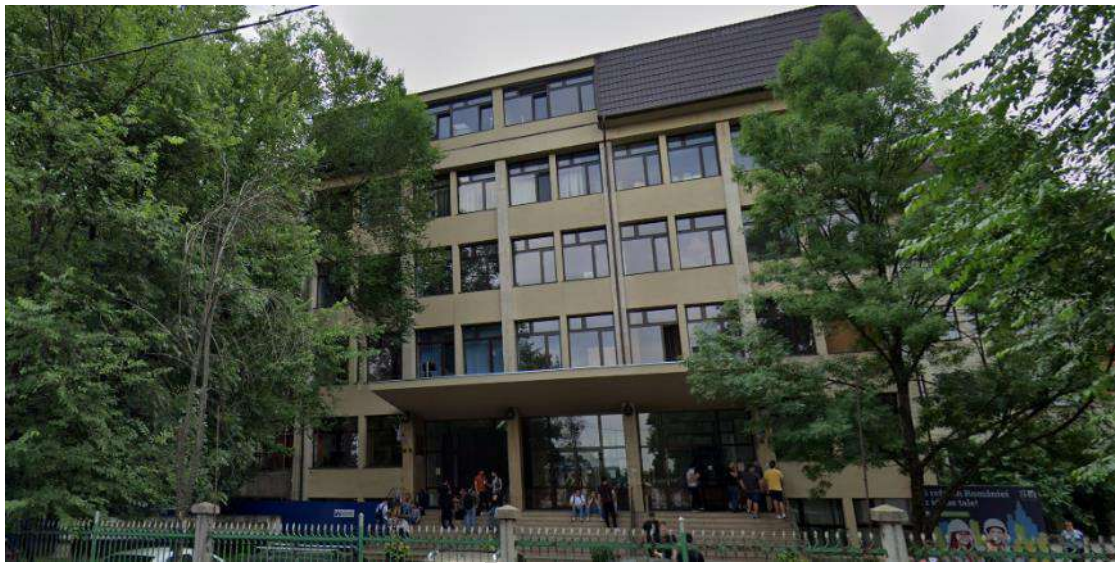
Figura 7.7 Clădire realizată înainte de 1977 cu structura în cadre de beton armat amplasată în București, înainte și după consolidare și reabilitare termică (sursa Google Maps)
