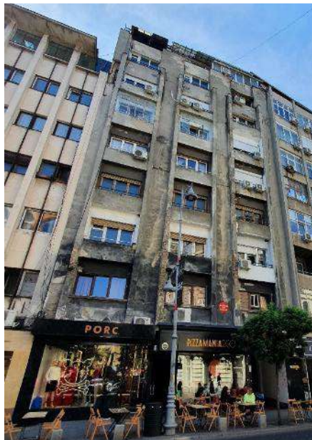
Figura 7.5 Clădire cu schelet din beton armat și pereți din zidărie de cărămidă, cu mai mult de 6 niveluri supraterane, realizată în perioada interbelică în București
