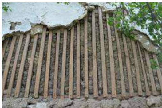
Figura 7.21 Pereți din paiantă realizați din rețele de șipci paralele și elemente de umplură
