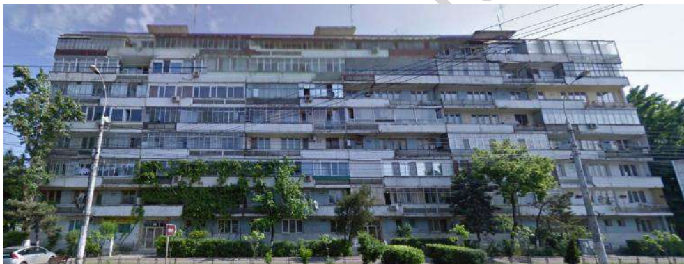
Figura 7.10 Clădire cu structura realizata din panouri mari prefabricate din beton armat amplasată în București, construită înainte de 1977 (înainte și după reabilitarea termică) (sursa: google maps)
