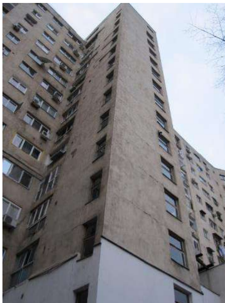
Figura 7.6 Clădire cu structura în cadre de beton armat amplasată în București
