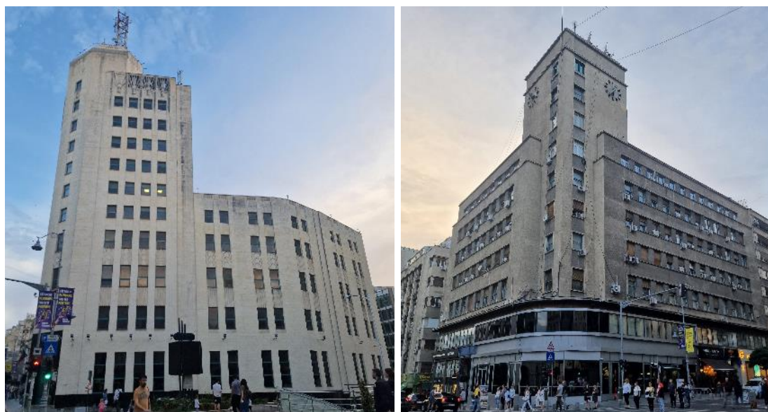
Figura 7.14 Clădiri cu structura în cadre cu noduri rigide din oțel amplasate în București (Palatul Telefoanelor, clădirea Adriatică)
