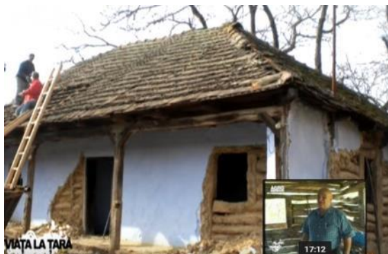
Figura 7.18 Structura cu bârne de lemn rotund
