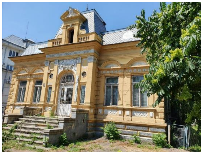
Figura 7.1 Clădire cu structura din zidărie nearmată și planșee flexibile la acțiuni în planul lor, amplasată în Focșani
