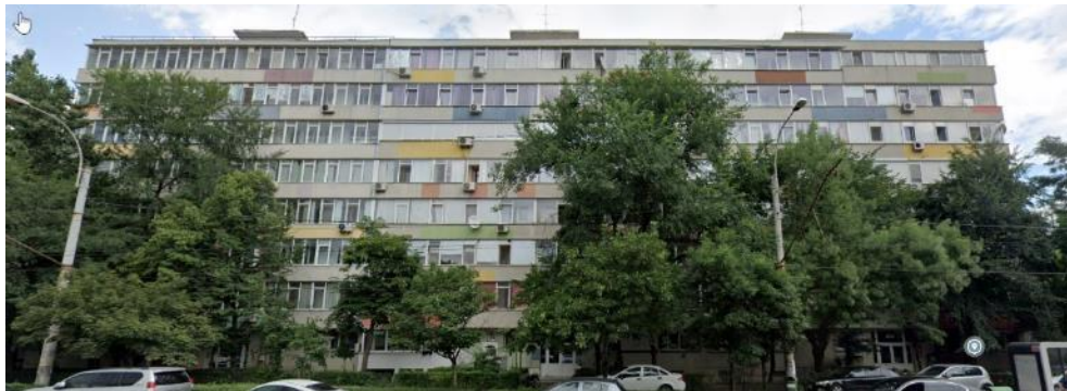
Figura 7.10 Clădire cu structura realizata din panouri mari prefabricate din beton armat amplasată în București, construită înainte de 1977 (înainte și după reabilitarea termică) (sursa: google maps)
