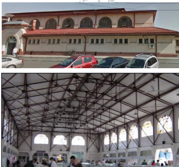
Figura 7.16 Clădire cu structura în cadre contravântuite din oțel amplasată în Brăila (Piața Halelor – vedere din exterior și vedere din interior )
