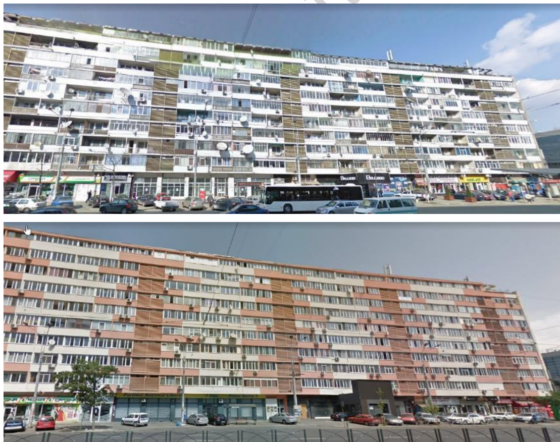
Figura 7.13 Clădire cu structura cu parter flexibil din beton armat amplasată în București, construită înainte de 1977 (înainte și după reabilitarea termică) (sursa: google maps)
