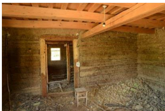
Figura 7.19 Structura cu bârne de lemn ecarisat
