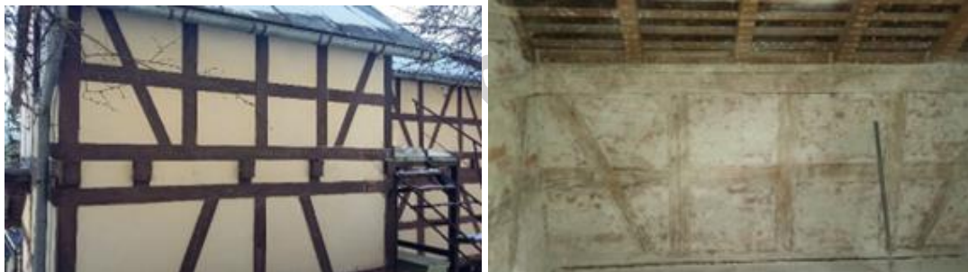
Figura 7.22 Casa cu structura din cadre de lemn și umplutura de zidărie
