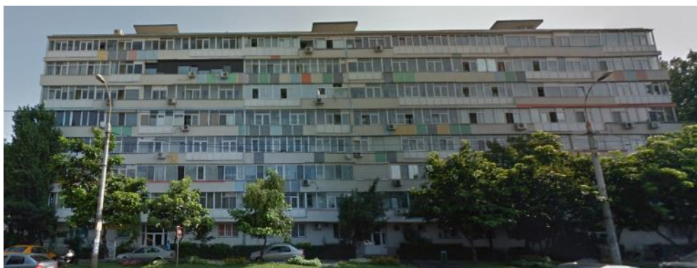
Figura 7.11 Clădire cu structura realizata din panouri mari prefabricate din beton armat amplasată în București, construită înainte de 1977 (înainte și după reabilitarea termică) (sursa: google maps)
