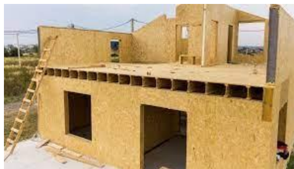
Figura 7.23 Casa cu structura din panouri de lemn
