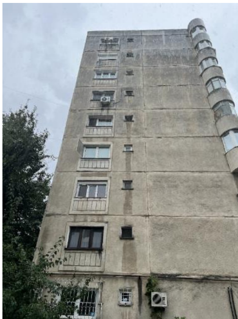
Figura 7.9 Clădire cu structura realizată din panouri mari prefabricate din beton armat amplasată în București
