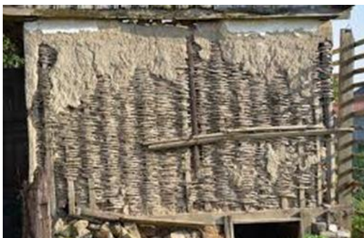
Figura 7.20 Casa cu perete structural din împletituri de nuiele
