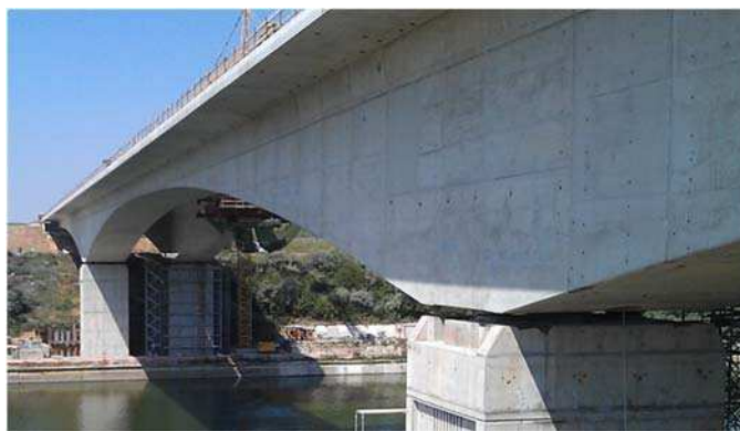
Figura 1. Vedere laterală a podului încercat
